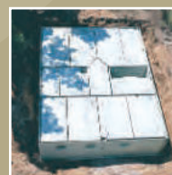
15:00 Uhr Der klimaPOR® Wohnkeller steht und ist voll tragfähig. Sämtliche Teile sind kraftschlüssig verbunden und der Innenausbau kann sofort weitergeführt werden.
