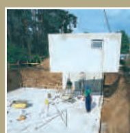
8:30 Uhr Die ersten Wandelemente werden aufgesetzt.
