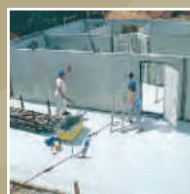
13:00 Uhr Die Wandmontage ist fertig und alle Vorbereitungen zum Auflegen der Deckenelemente sind getroffen.
