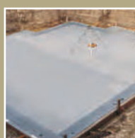
8:00 Uhr Die Bodenplatte ist zum Aufbau vorbereitet.
