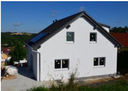
Fassade mit Endputz
