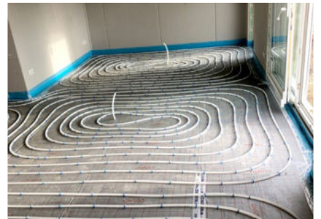
Rohinstallation Heizung & Sanitär
